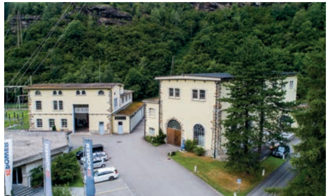
La centrale idroelettrica di Robbia
