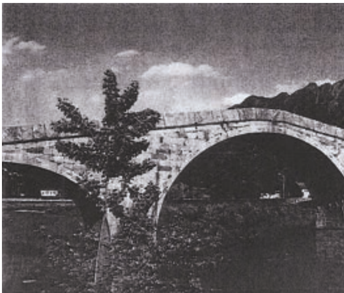
Ponte settecentesco di Ganda
